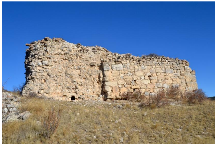
Lateral occidental del edificio principal, en el que se aprecia la antigua torre (derecha) y el primer bloque adosado, a la izquierda
