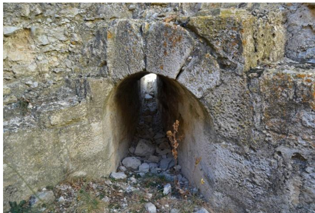
Una de las aspilleras semienterradas del edificio principal.
